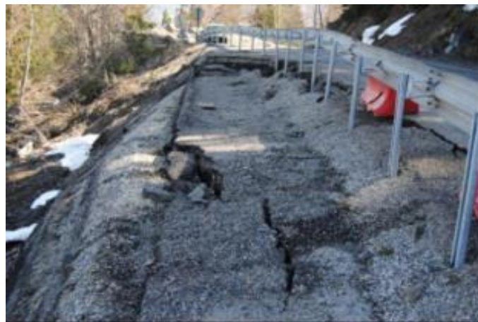
Figure 11. Photos des déformations et affaissements de la chaussée.
