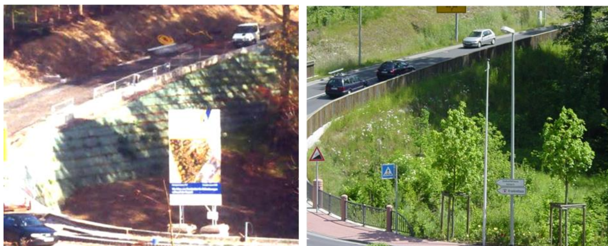
Figure 1. Talus raide renforcé, phase de construction (à gauche) et phase d'exploitation (à droite).
