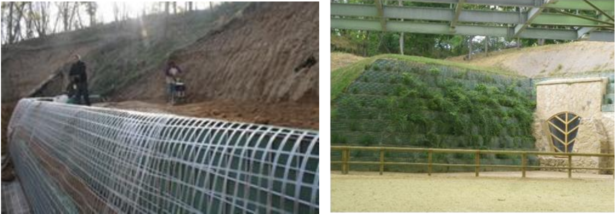
Figure 10. Photos en cours et après réalisation.
