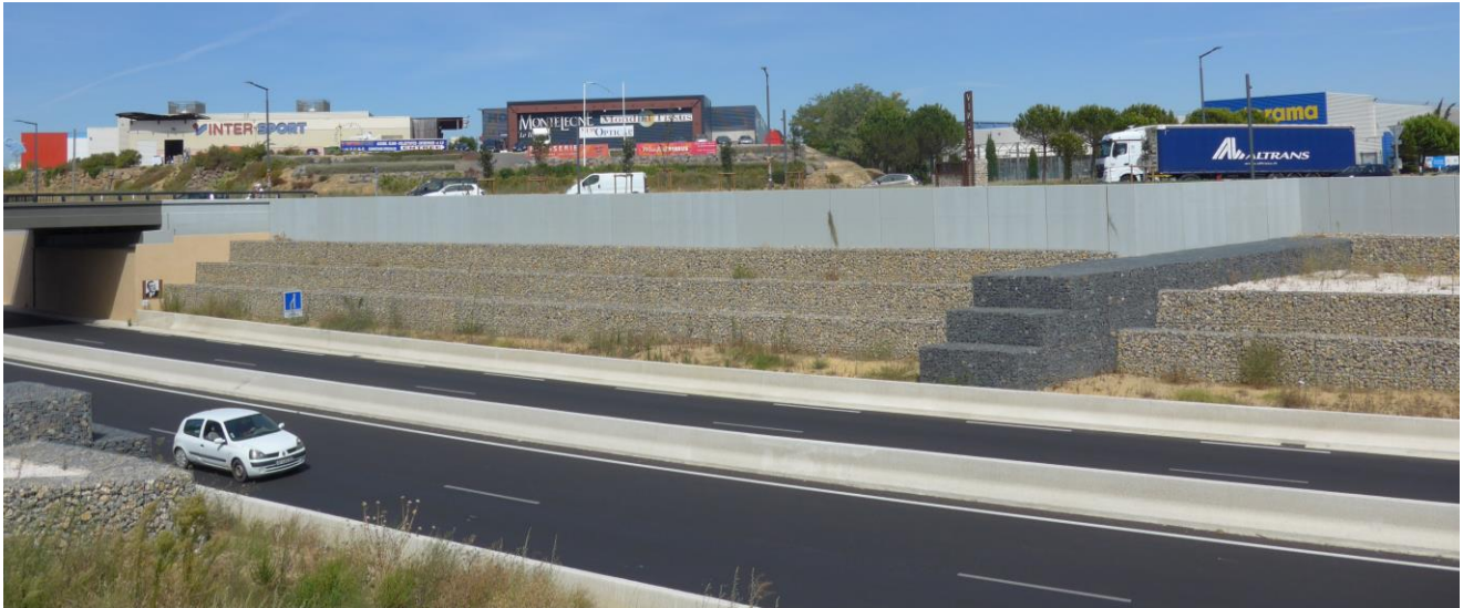
Figure 9. Photo de l'ouvrage en exploitation.
