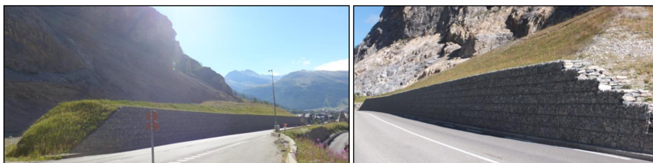
Figure 6. Photos de l'ouvrage.
