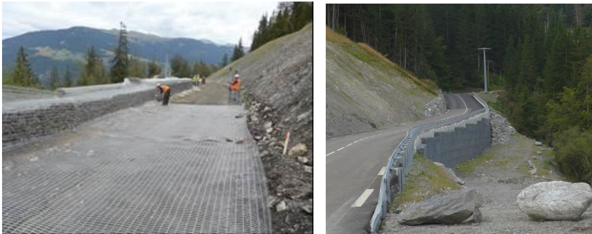
Figure 12. Photos en cours et après réalisation.
